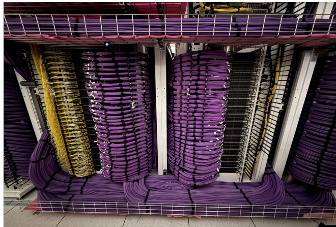
图 1-6 铜缆和光纤的部署对比 [5]
